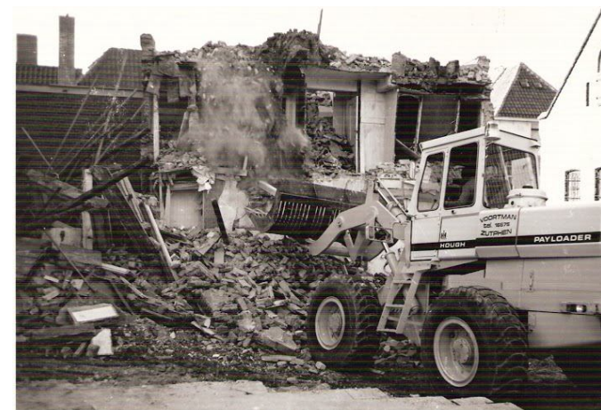
foto 8 Sloop middeleeuwse huizen aan de Dieserstraat in 1976
