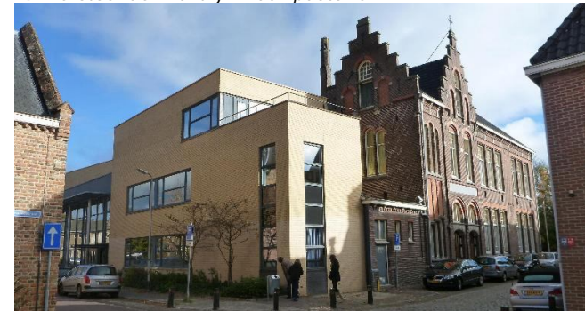
foto 15 Detonerende nieuwbouw op historische locatie
