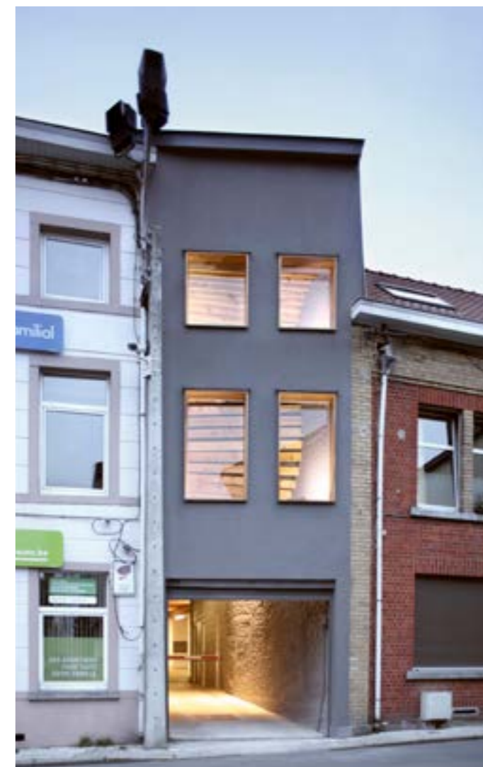
Toegang parkeergarage geïntegreerd in poortwoning
