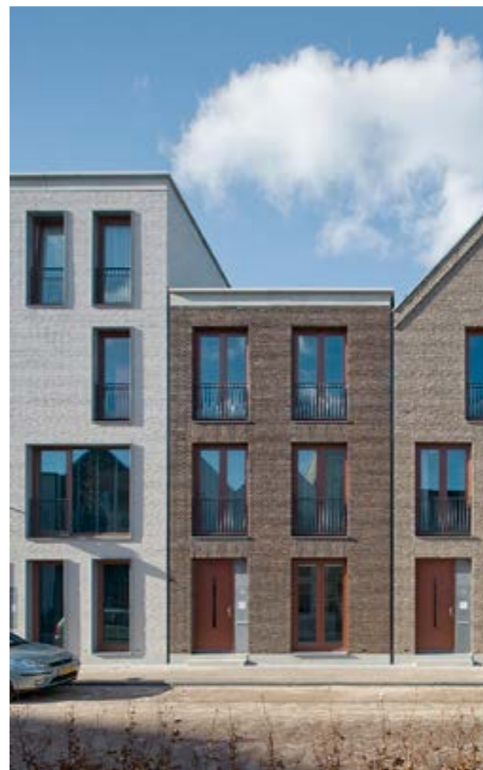
Hemelwaterafvoer aan straatzijde teruggelegen in gevel
