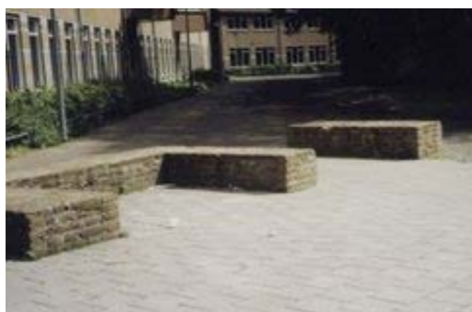
Fundamenten van de Reinmakerstoren in de Isendoornstraat
