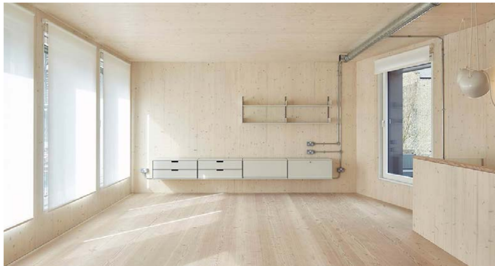
Scheiding constructie en installatie
