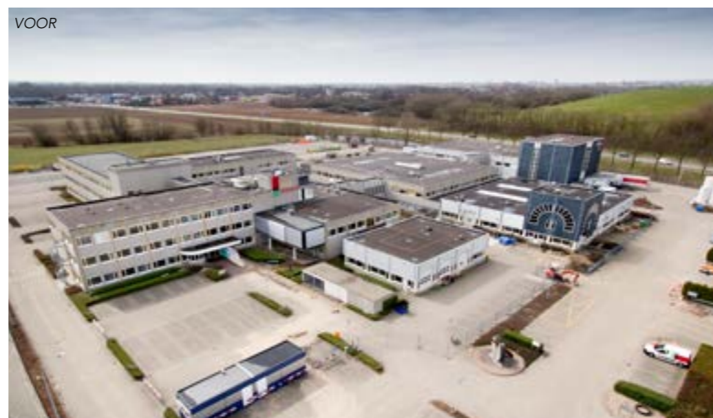
Liander, RAU: Bestaande bouw herbestemmen ipv slopen en materialen uit reststromen zoals de houten gevelbekleding
