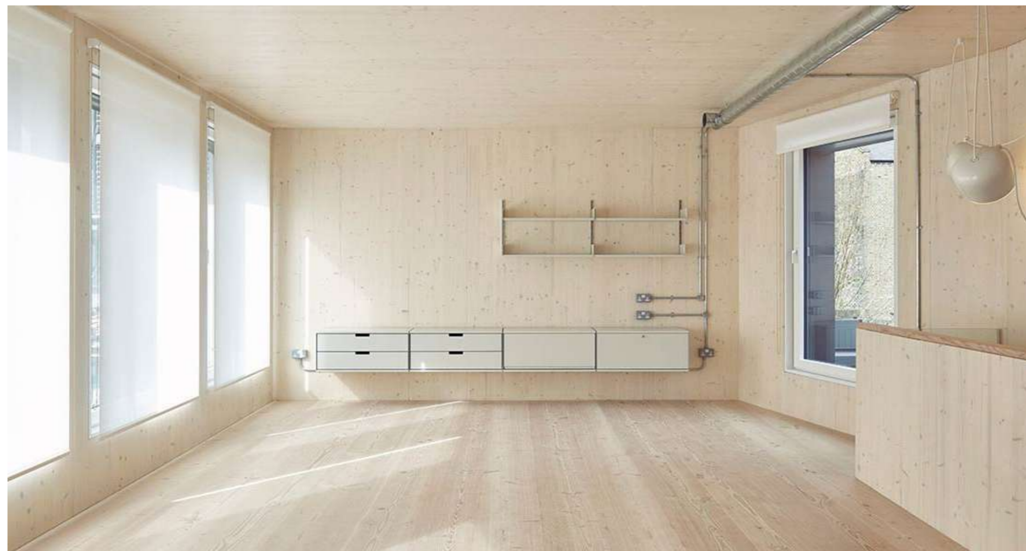
Scheiding constructie en installatie
