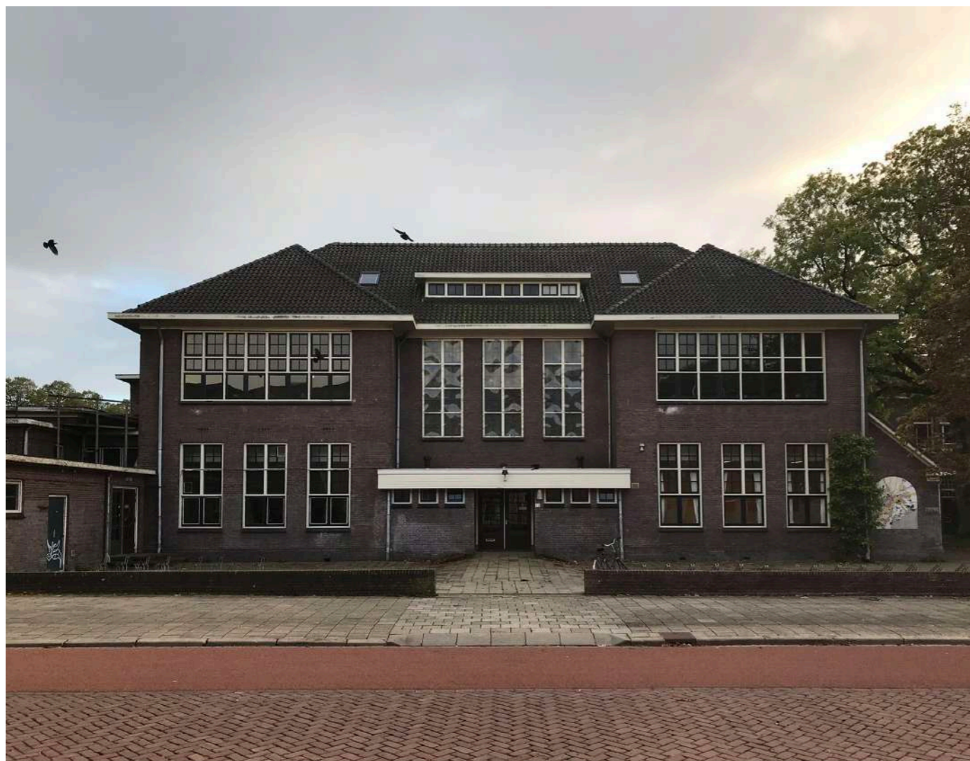
Bestaand St. Joseph School gebouw
