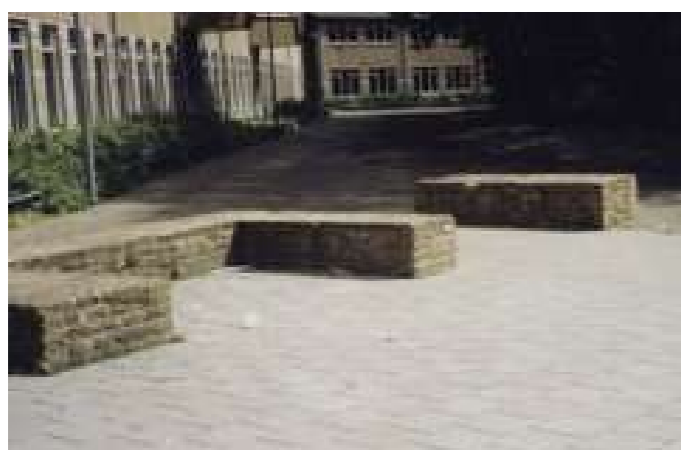
Fundamenten van de Reinmakerstoren in de Isendoornstraat
