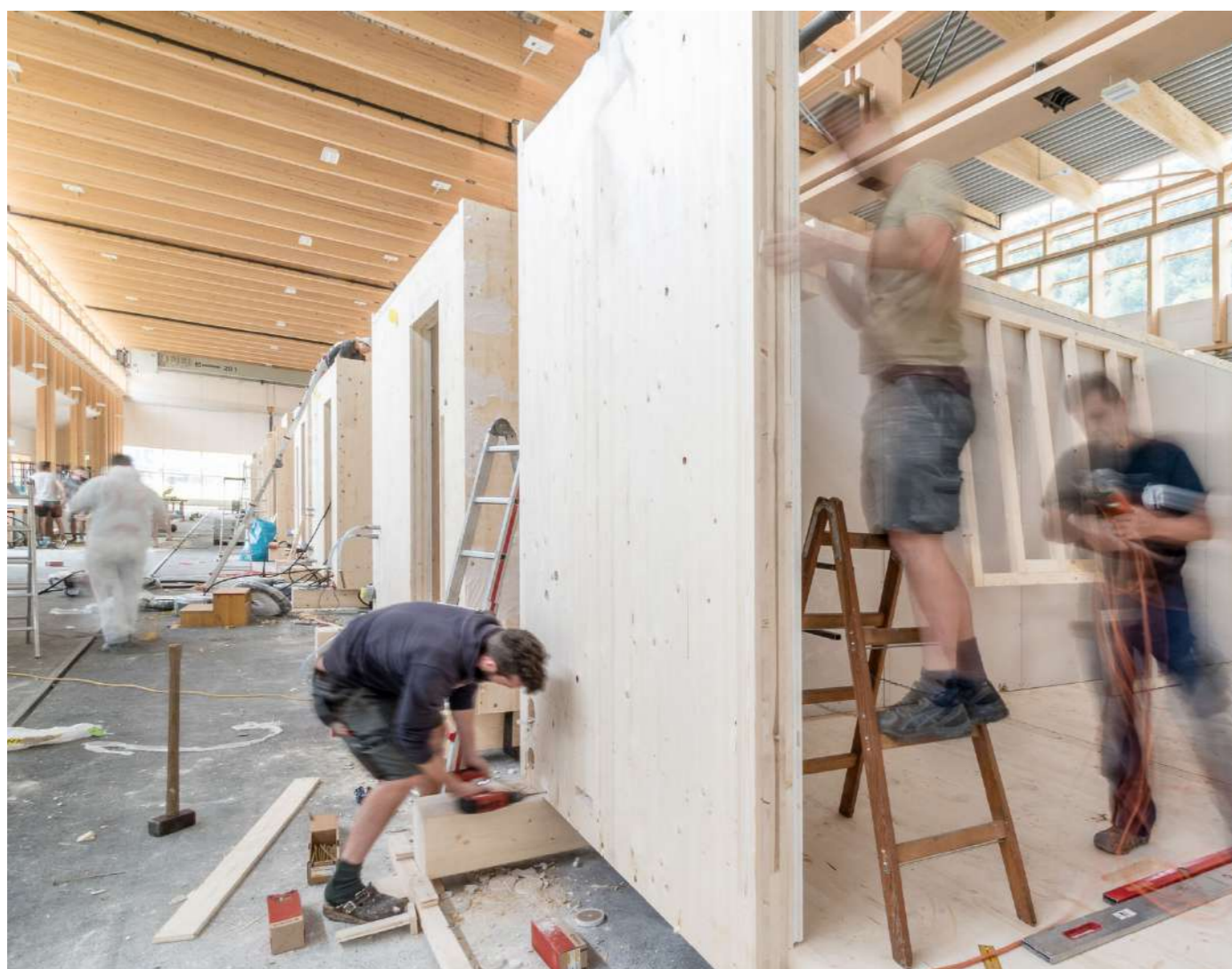
Houten modules: Prefabricage in de fabriek van de producent
