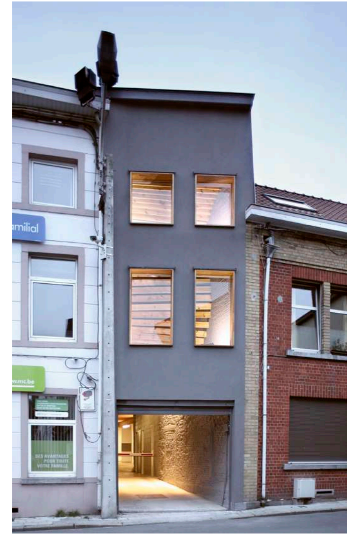
Toegang parkeergarage geïntegreerd in poortwoning
